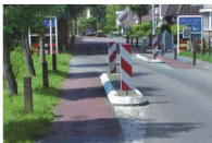
DOBRE: uspokojenie ruchu poprzez zwężenie jezdni z pozostawieniem przepustów dla rowerów (Nieuwveen, Holandia).
